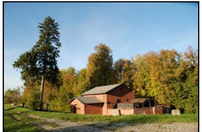
Fot. 18. Maszynownia przy pochylni Kąty
