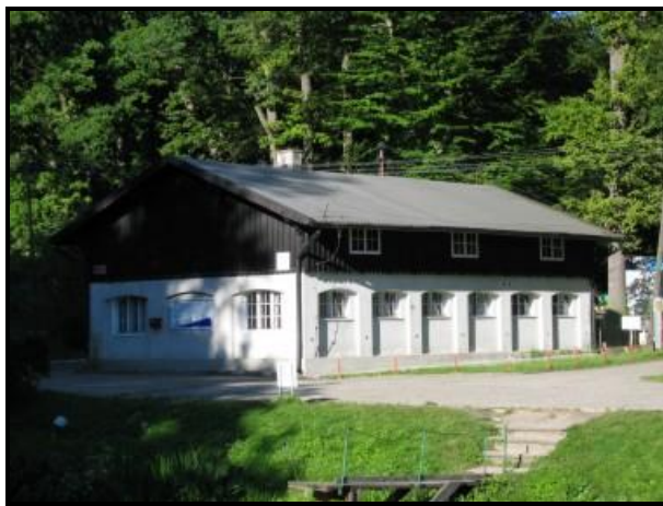
Fot. 20. Izba Historii Kanału Elbląskiego
